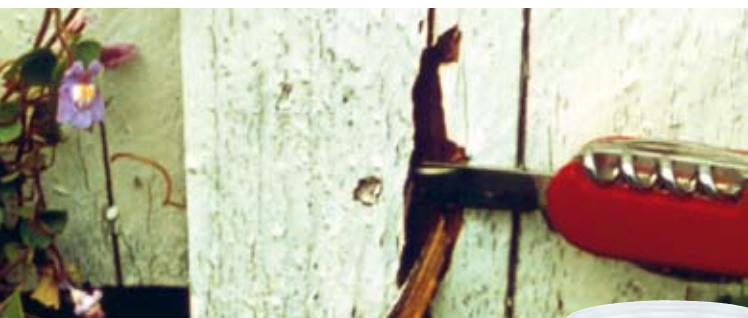
Holzfäule entsteht durch schlechten Holzschutz
